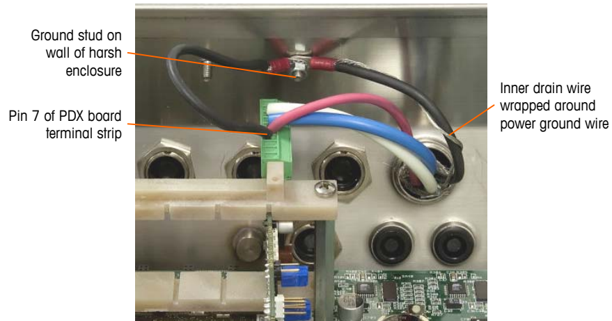
Figure 2-47: Connexion de la masse de l'alimentation du circuit autonome PDX, environnement difficile
